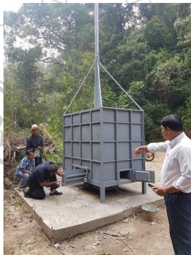
ภาพที่ 4.15 การติดตั้งเตาโดยการเทพื้นซีเมนต์เป็นฐาน
