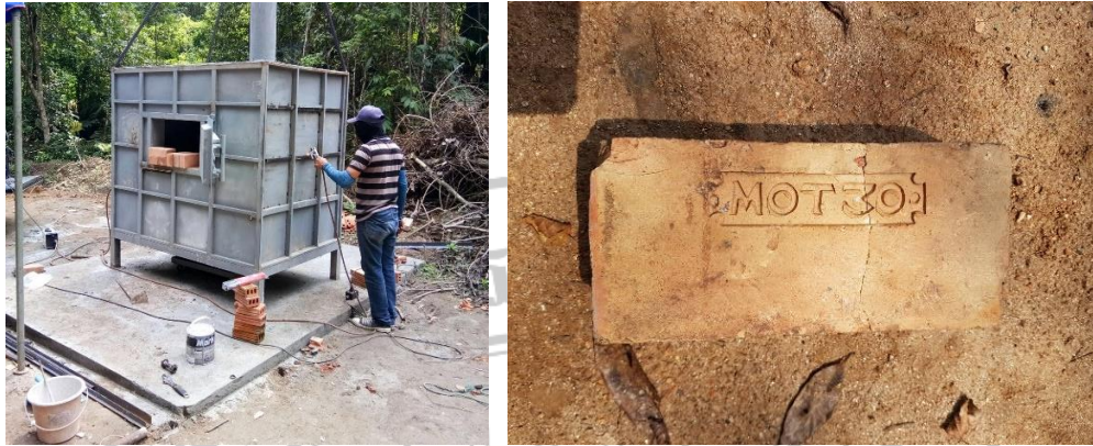
ภาพที่ 4.16 การก่อผนังด้านในของห้องเผาด้วยอิฐมวลเบา
