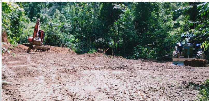
ภาพที่ 4.12 การปรับพื้นที่เพื่อเตรียมติดตั้งเตาเผาและเป็นจุดกำจัดขยะของชุมชน
